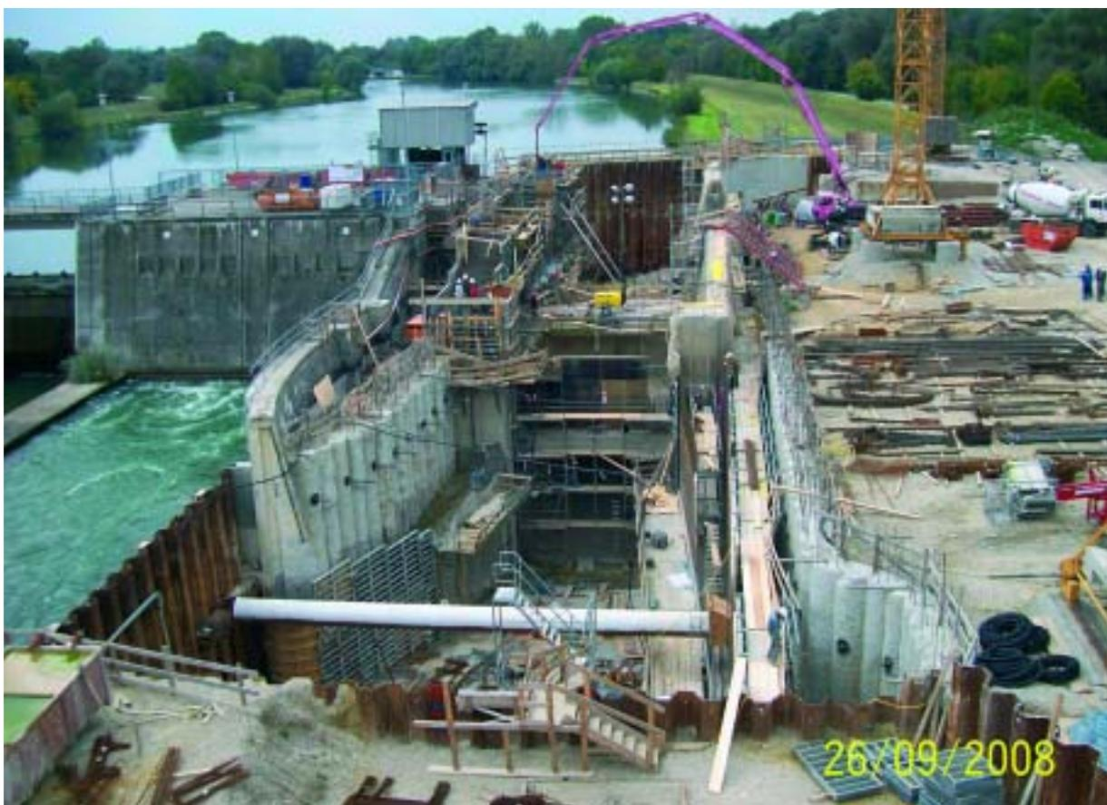
Bauarbeiten an der Staustufe Gottfrieding – Neubau des Triebwerkes
