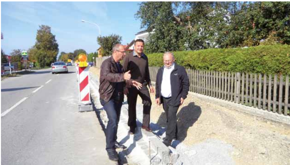
Baustellenbesprechung im Bereich der St 2074 (alte B11) zum Neubau des Geh- und Radweges.
