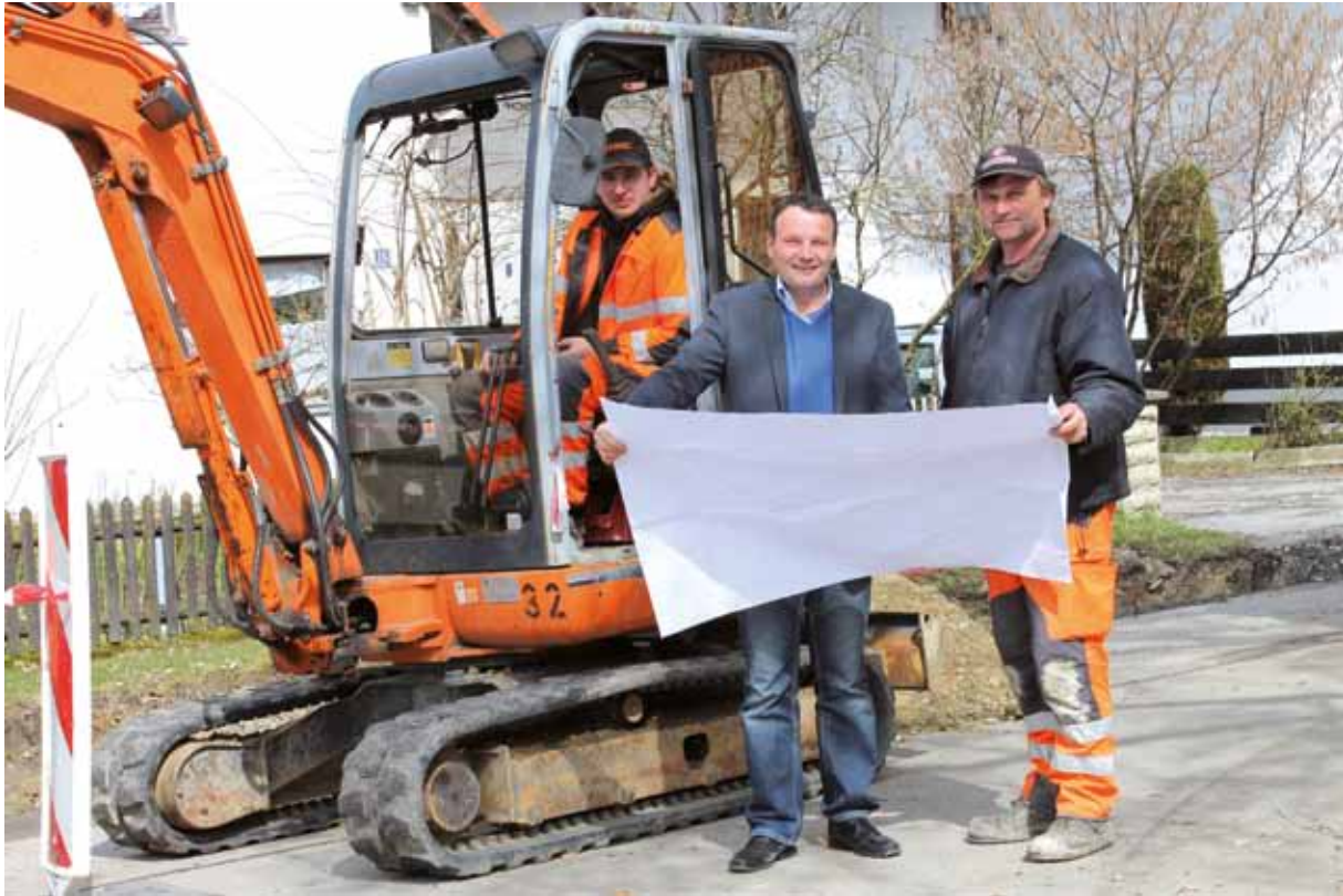
Baustellenbesprechung zur Sanierung der Ortsdurchfahrt Frichlkofen
