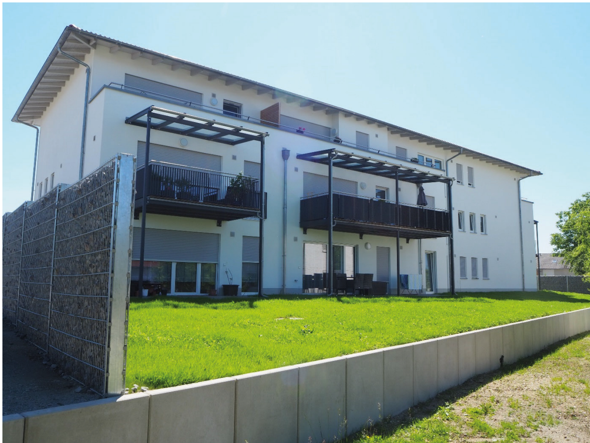
15 Wohneinheiten wurden in der Gottfriedingerschwaige geschaffen.
