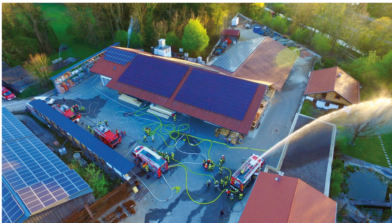
Feuerwehrgroßübung auf dem Gelände der Fa. Konrad Hausbeck
