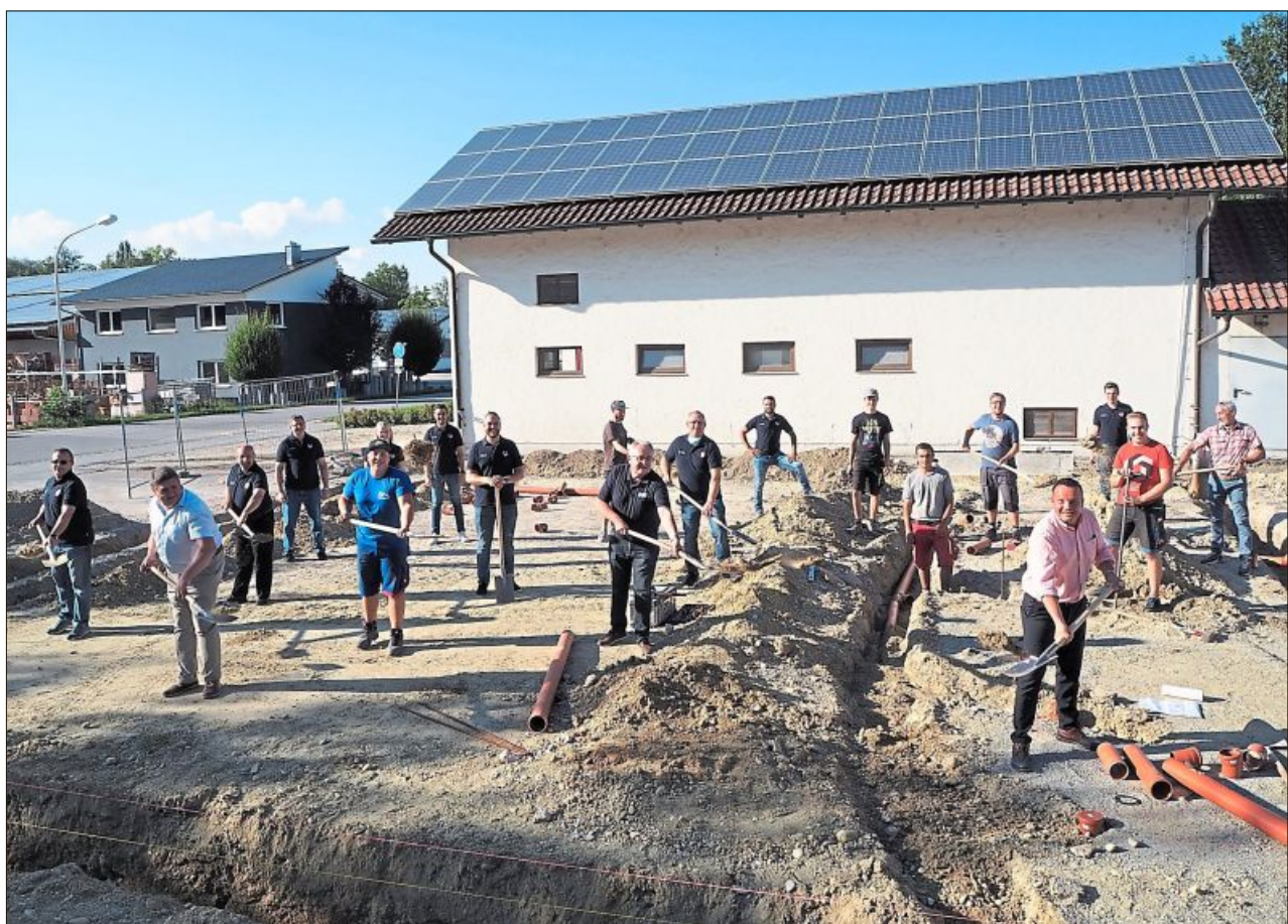
Der Spatenstich ist gemacht, jetzt wird gebaut.
