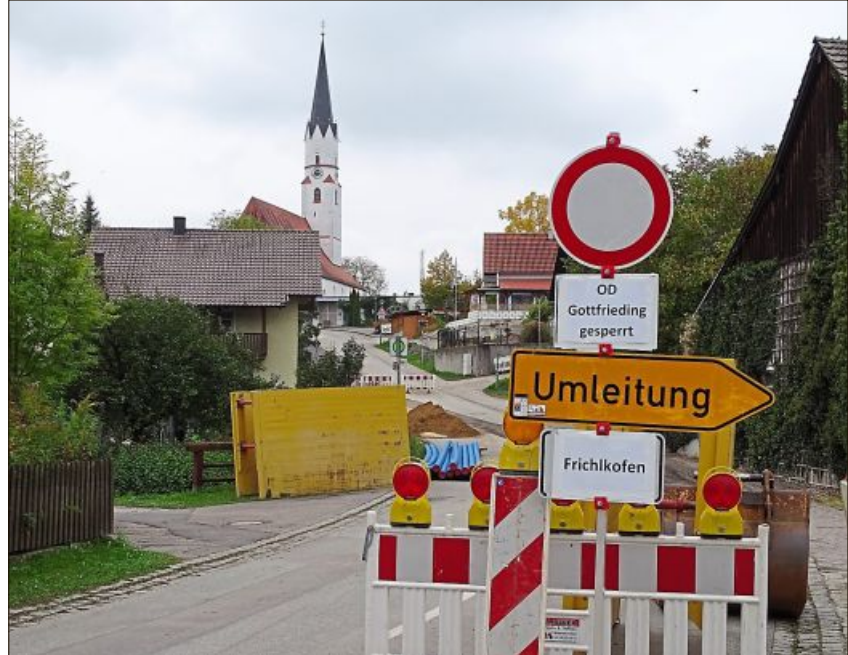
Die Straßenbaustelle am Kirchenberg ist ein großes Vorhaben. Sie wird erst im November abgeschlossen werden können.
