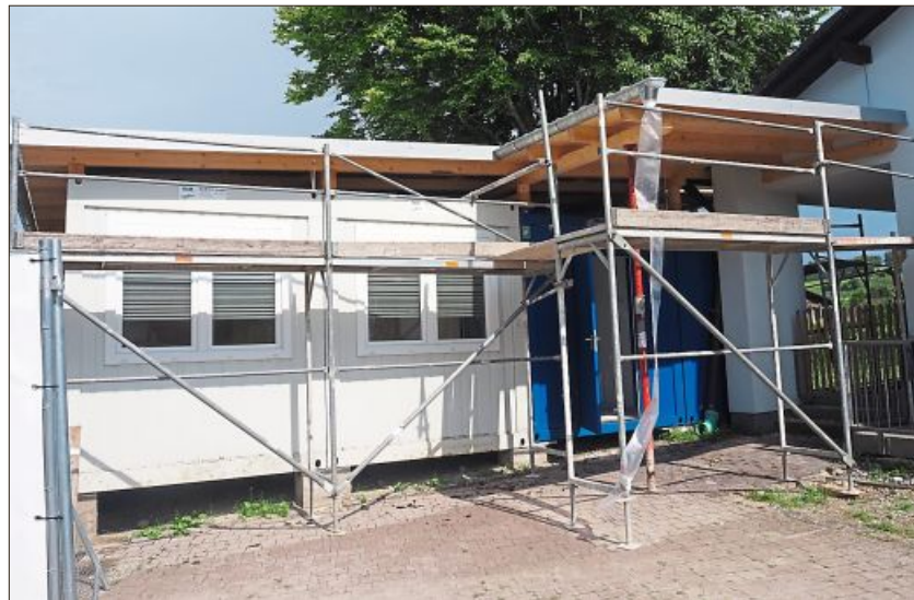
Eine Gruppe in Modulbauweise entsteht.
