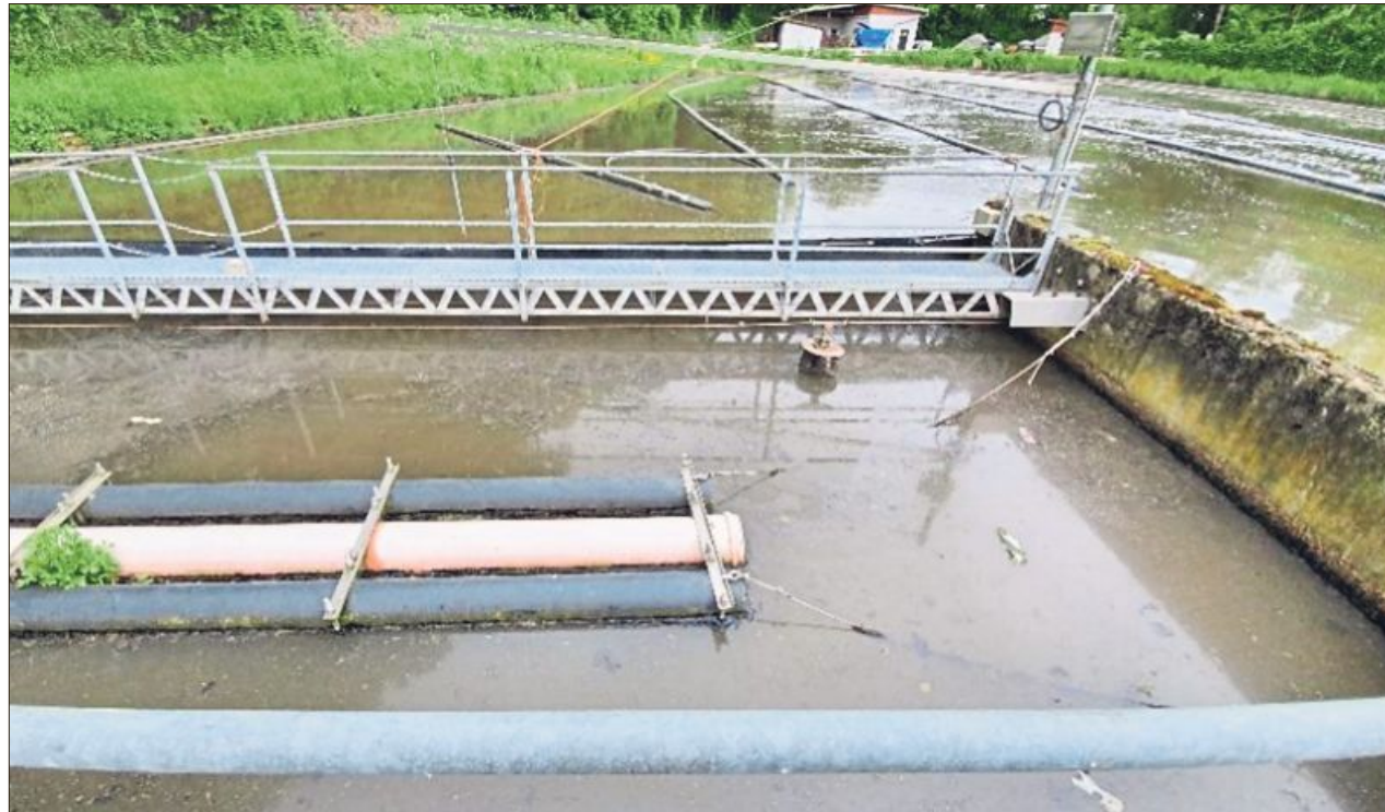
Wichtiges Thema: Abwasserklärung. In der Verwaltungsgemeinschaft Mamming-Gottfrieding muss schnell gehandelt werden. Mehrere Millionen an Baukosten sind im Gespräch.
