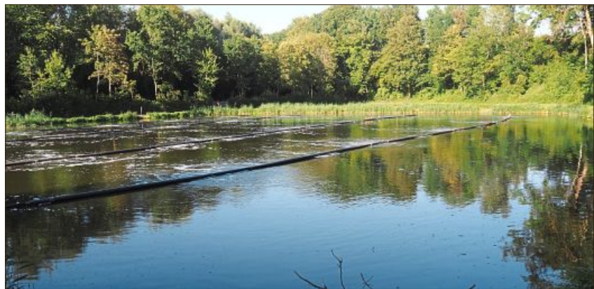
Der Teich 2 soll während der Bauphase die Klärung übernehmen.
